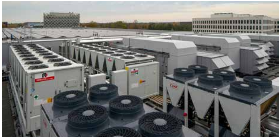
De installatie werd voorgeassembleerd en in verschillende grote modules naar de bouwplaats getransporteerd.
