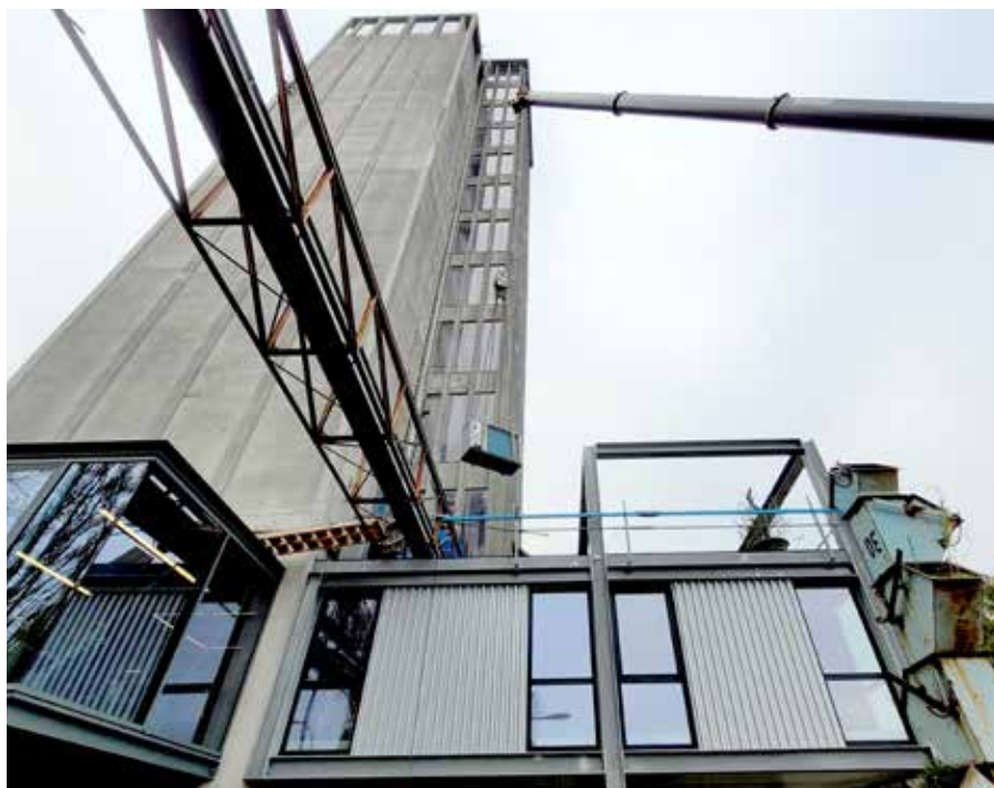
Een CHA-monoblock wordt omhoog gehesen.
