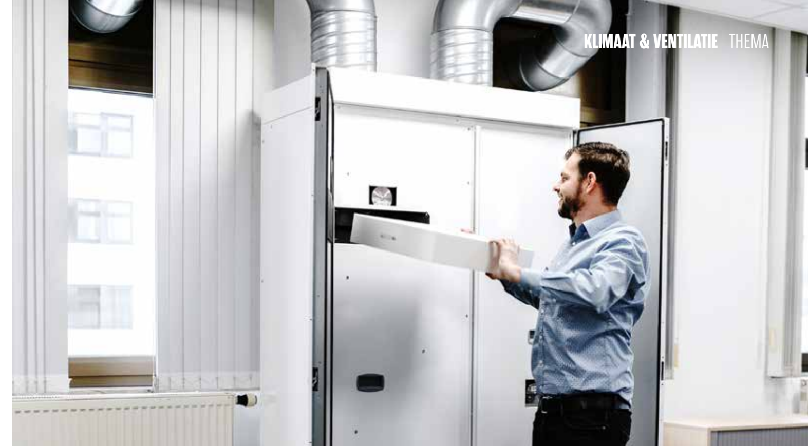
De hoogwaardige filters zijn eenvoudig uit te wisselen. Een tweede filtertrap is optioneel.
