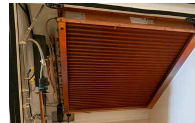
De gehele luchtbehandelingskast is chloorluchtbestendig uitgevoerd. Zo zijn bijvoorbeeld de verdampers en condensator volledig uit koper vervaardigd.
