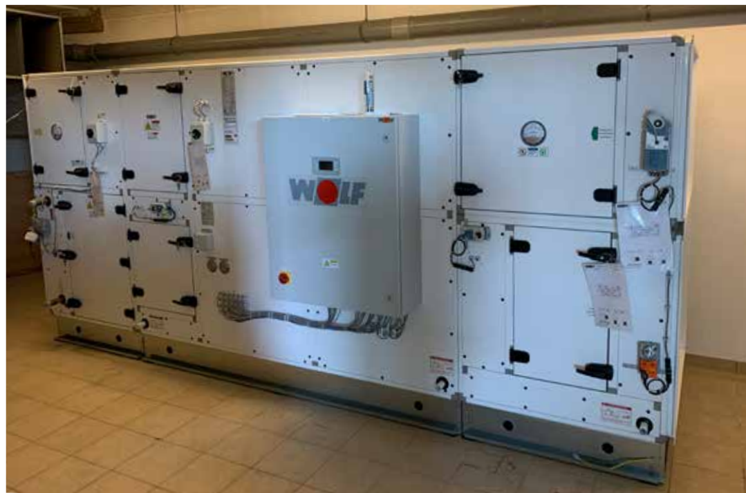
De KG Flex Pool zorgt dat circa 85% van de warmte uit de afgevoerde zwembadlucht wordt teruggewonnen.
