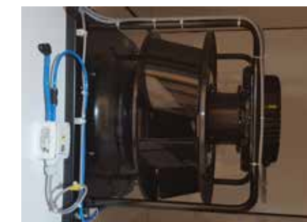
Energiezuinige gelijkstroomventilatoren in een corrosiebestendige uitvoering.
