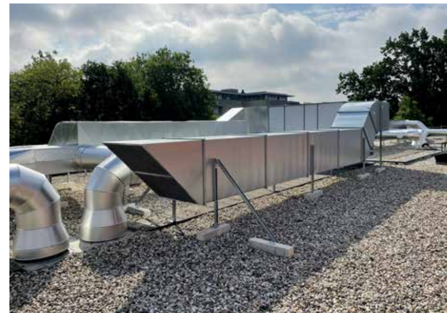
De verdunningsfactor en minimale afstand tussen aanzuig en retour zijn zorgvuldig berekend om contaminatie van lucht te voorkomen.
