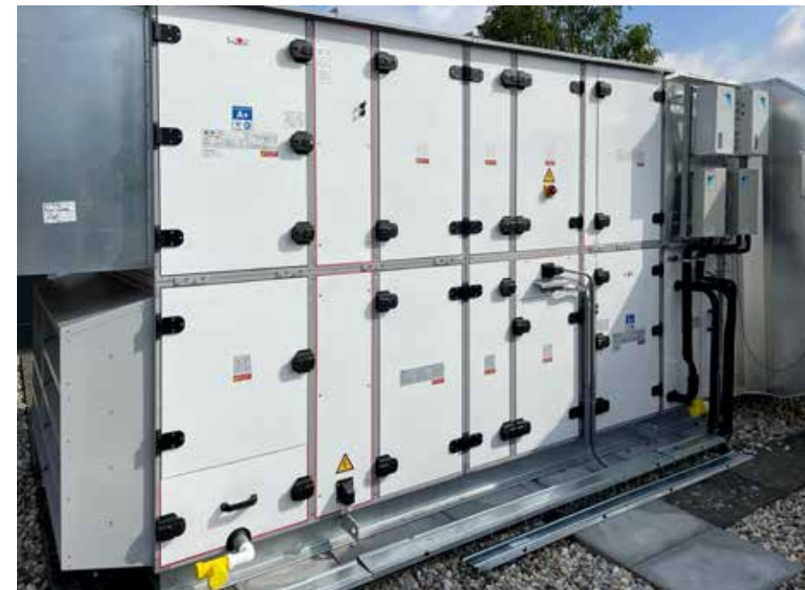
De WOLF CRL compactunit voorziet de lokalen van verwarming en koeling.
