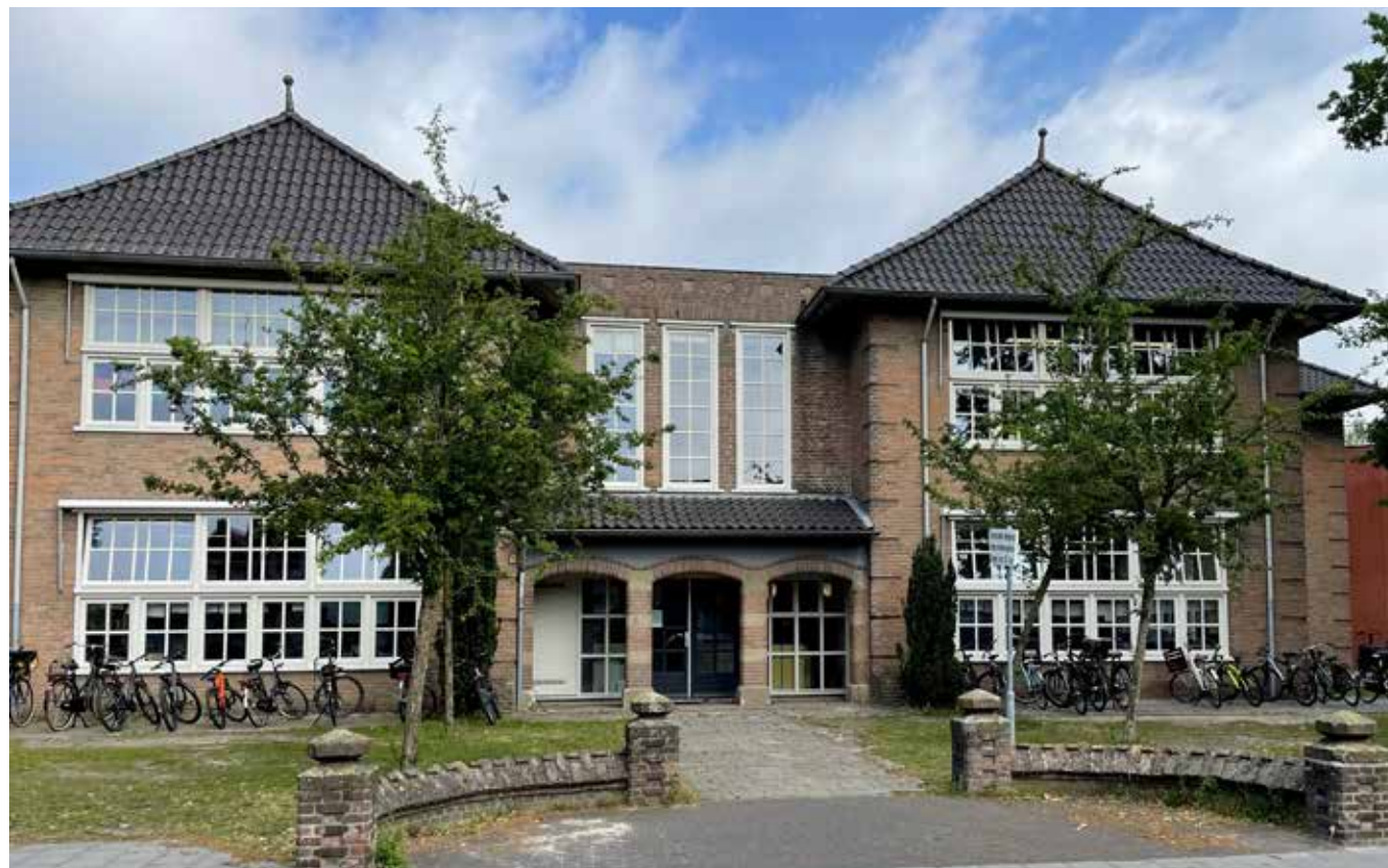
In het monumentale gedeelte regelen de comfort-plafond WTW-units de ventilatie standalone op basis van CO 2 .
