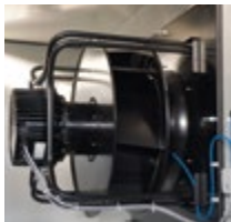
3 Ventilatoren mit EC-Motor und einge- bautem Messsystem zur Volumenstrom- bestimmung
