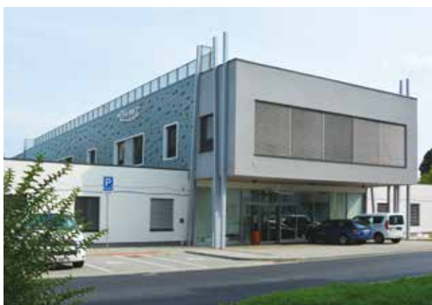
Alzheimer centrum Ostrava vzduchotechnické jednotky KG Top
