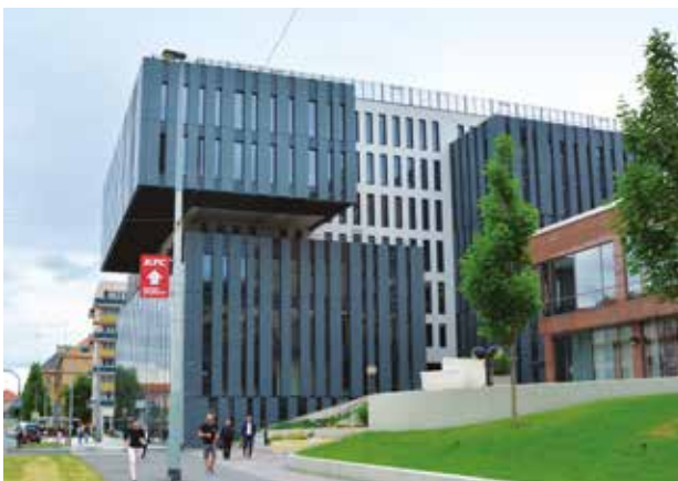
EGATE Evropská, Praha vzduchotechnické jednotky KG Top
