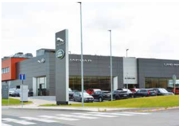
Autosalon Čestlice vzduchotechnické jednotky KG Top
